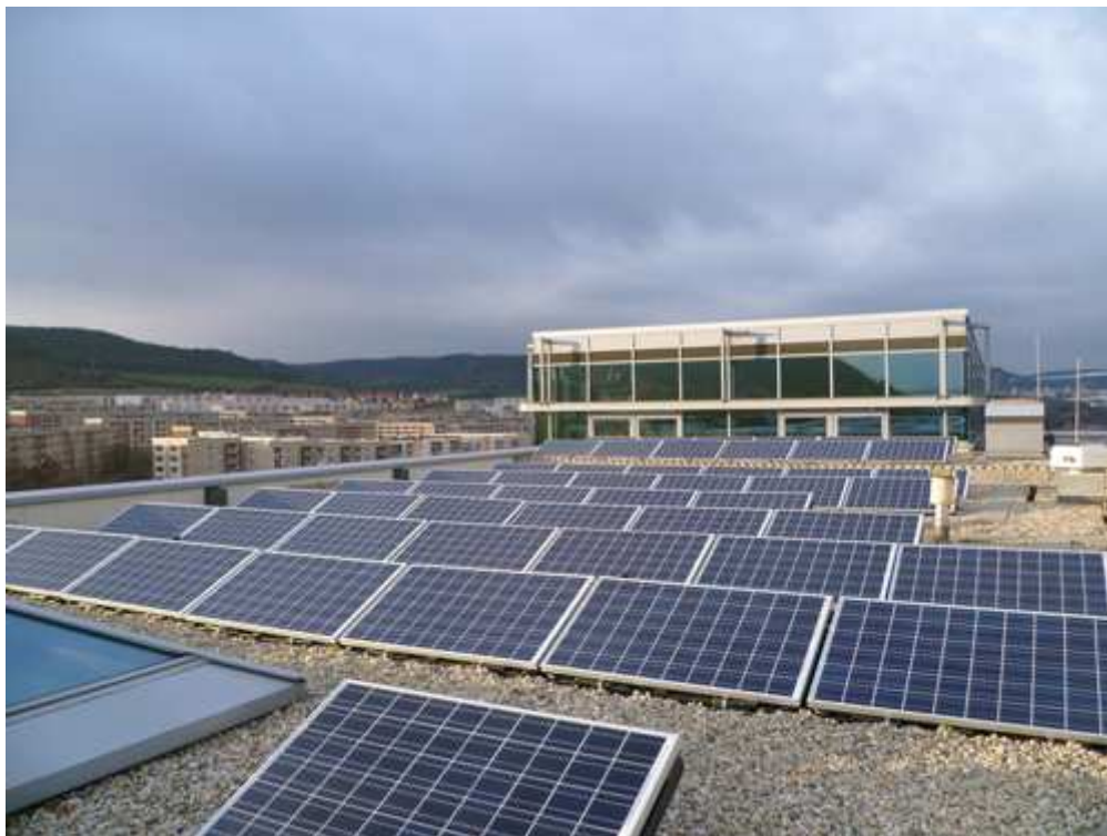
Foto: Stadtwerke Jena
